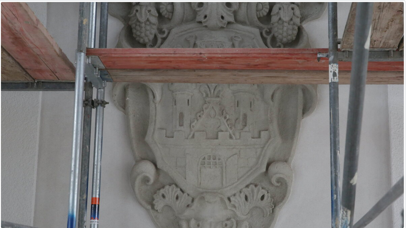
Das alte Kamenz-Wappen als Relief wurde an der früheren Außenwand restauriert. Es befindet sich nun im Verbindungstrakt zwischen Alt- und Neubau. © Matthias Schumann
