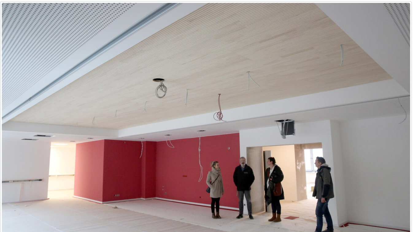
So sieht eines der künftigen Lehrerzimmer aus. © Matthias Schumann
