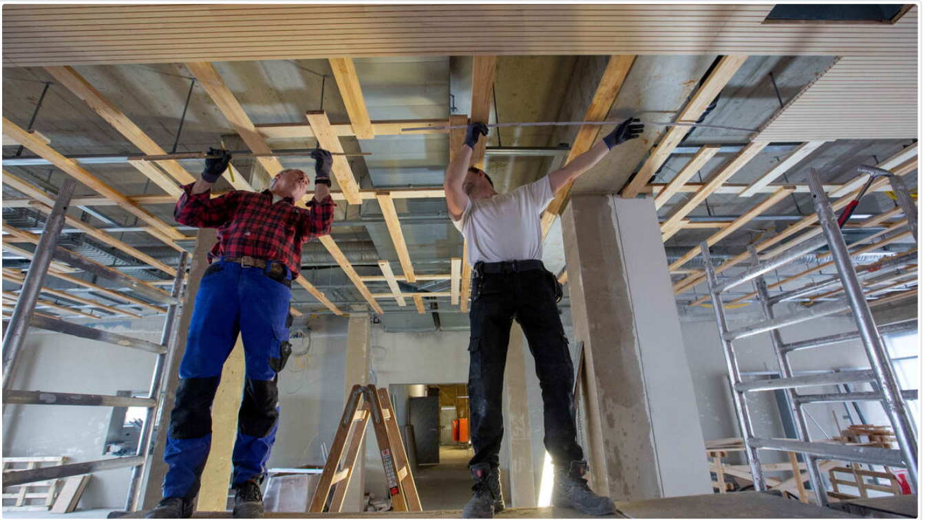
Die neuen Stadtbibliothek bekommt ein Holzakustik-Decke. © Matthias Schumann
