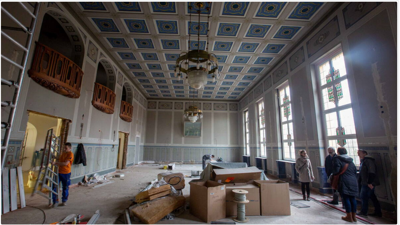
Die historische Aula im Altbau der Lessingschule bekommt ihren alten Glanz zurück. Hier wurde auch eine neue Geschosdecke eingezogen. © Matthias Schumann
