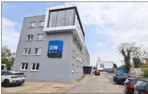
Ein Unternehmen, das seinen Wurzeln treu bleibt – der sanierte Firmensitz in Kamenz an der Nordstraße
