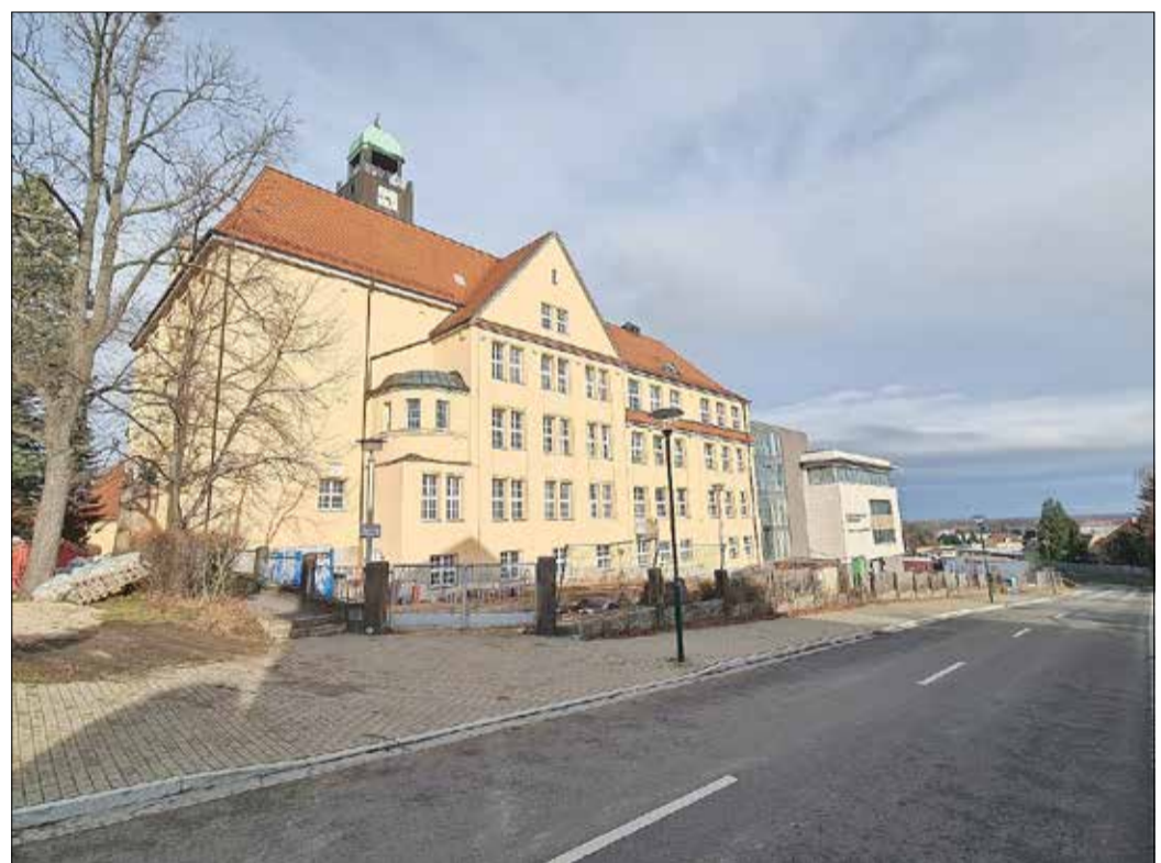
Im neuen Jahr: Lessingschule mit Verbindungsgebäude zum Erweiterungsneubau – 09.01.2022
