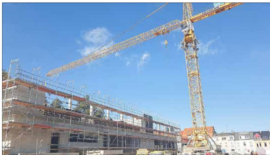
Erweiterungsneubau an der Lessingschule am 20. September 2020
