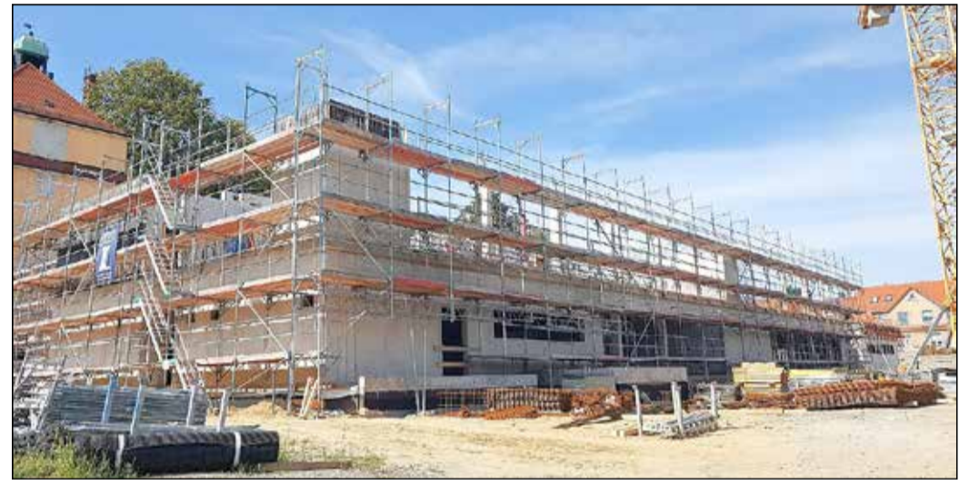
Baufortschritt an der Henselstraße (13. September 2020)
