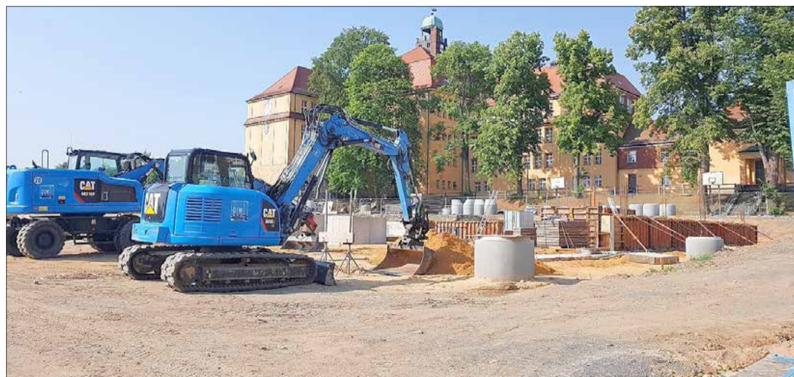
Vor dem historischen Schulgebäude an der Henselstraße wächst der Erweiterungsneubau (Stand 13.06.2020)
