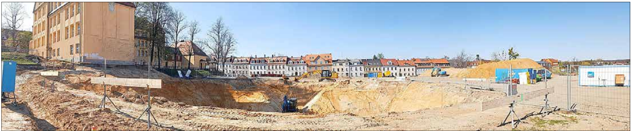
Stand der Bauarbeiten an der Lessingschule am 12.04.2020
