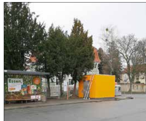
WC-Container während der letzten Vorbereitungsarbeiten und vor der Inbetriebnahme
