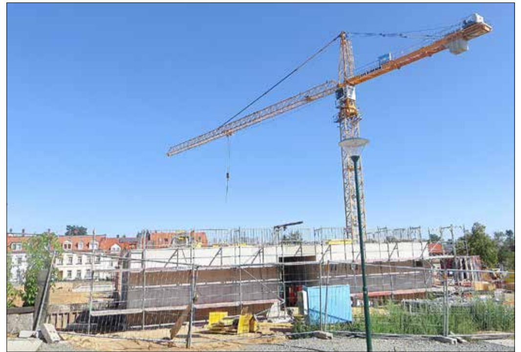
Stand der Bauarbeiten am Erweiterungsneubau Lessingschule am 27.07.2020
